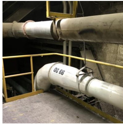
Alt Feed/Dust Collection Fan & Pipe
